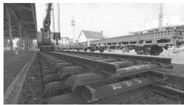
Ende der 90er-Jahre wurde das Gleisbett am Burgsteinfurter Bahnhof demontiert.
